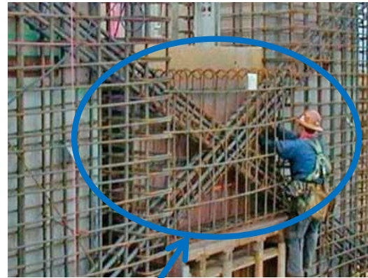
Betonarme Bağ Kirişi
